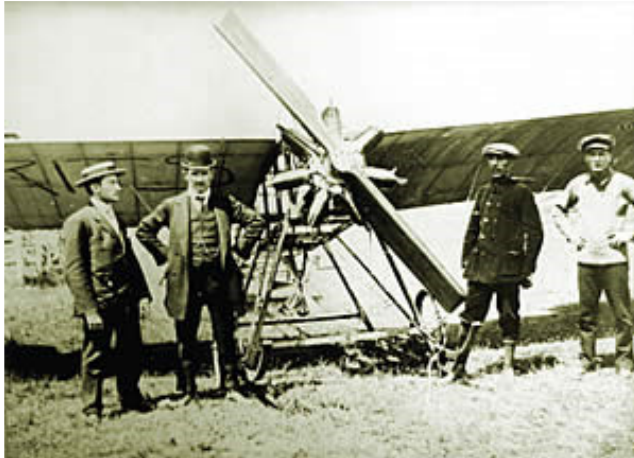
Avion "Sarić II-A" iz 1911. sa "Delfos"-ovim sedmocilindričnim rotativnim motorom od 44 kW (60 KS). Na slici Artur Delfos, župan Janoš Purgli, Ivan Sarić i Oskar Ašbot, sa kojim je izradio uglastu elisu.
